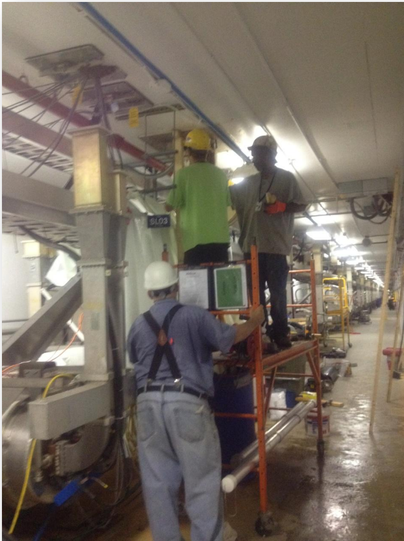
Installing E-Plates and Shoring for Grout Pour
